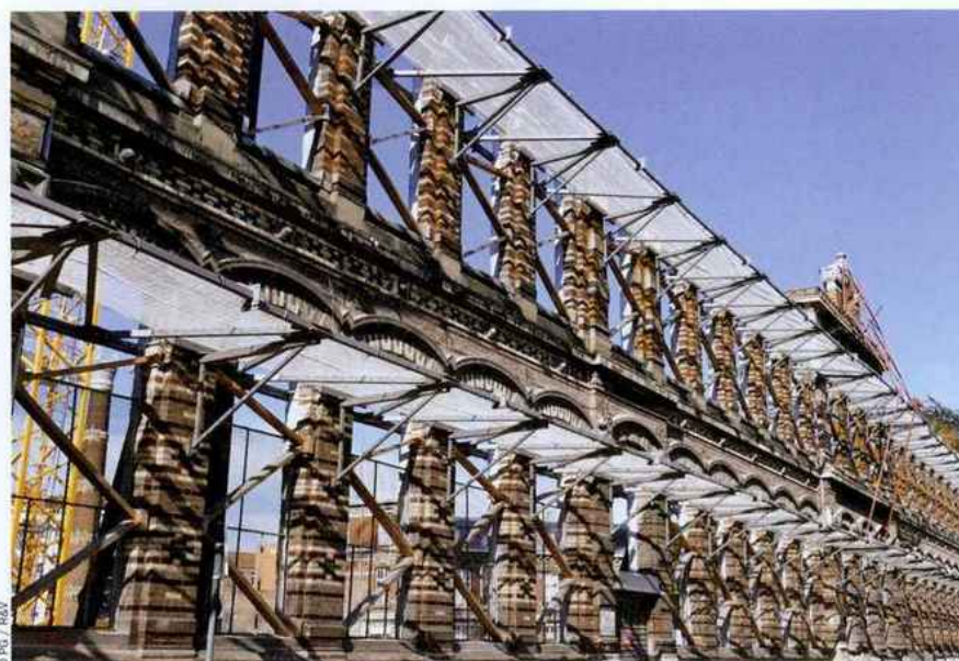
© PG / RSV Déconstruction à Lille. Les façades sont conservées, autant d'ouvertures pour gérer les déchets de déconstruction et des travaux de rénovation et de construction.
